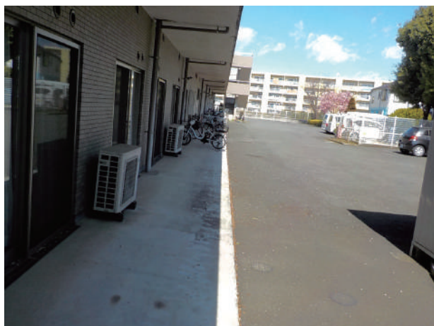
写真5 レッドゾーンで対応する介護職員は出勤したら施設の玄関を通らずに外から中に入る。
