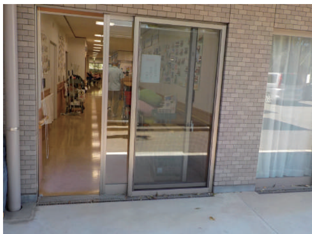
写真6 レッドゾーンのユニットの出入り口
