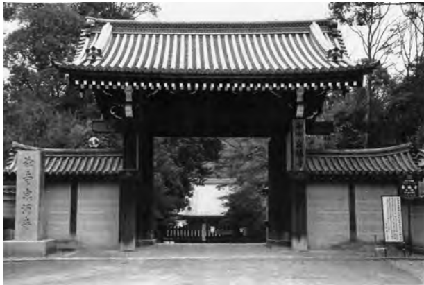
【写真32】京都、泉涌寺山門（重要文化財）。
